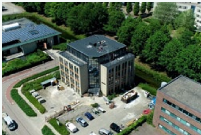
3 warmtepompen appartementen in Amersfoort. Aquarea
