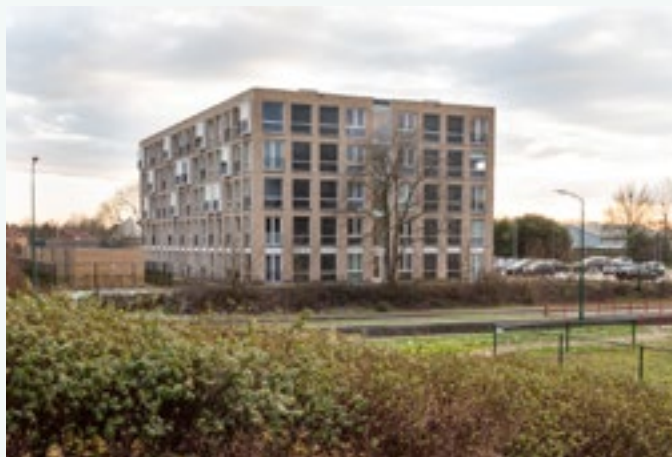
75 Warmtepompen appartementen Cuijk. Aquarea All in One
